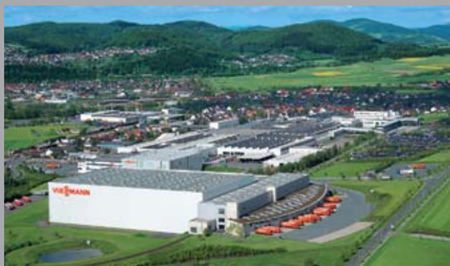
Завод Viessmann в г. Аллендорф / Германия
